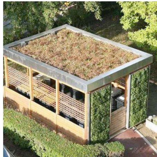
Un local à poubelles esthétiquement camouflé à Saint-Maur-des-Fossés (94) © Sébastien Briatte
