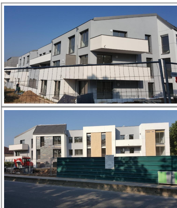
Chantier « Moulin Vert »
